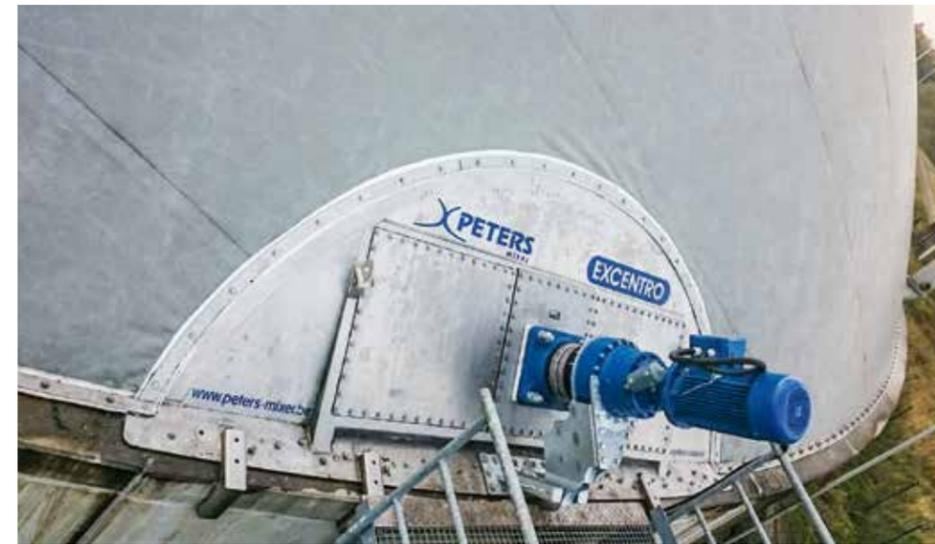
Le système Methabox® de Peters Mixer permet un montage en toute facilité dans les toits à double membrane d'installations biogaz.
